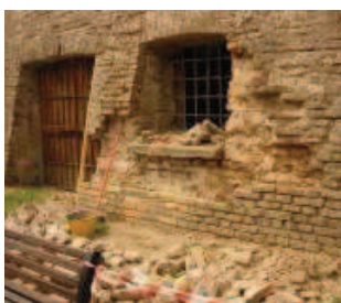
Due immagini del cantiere aperto presso le mura di Gera
