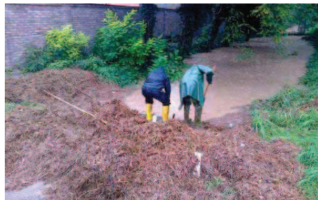
I lavori nei pressi del colatore Pippia
